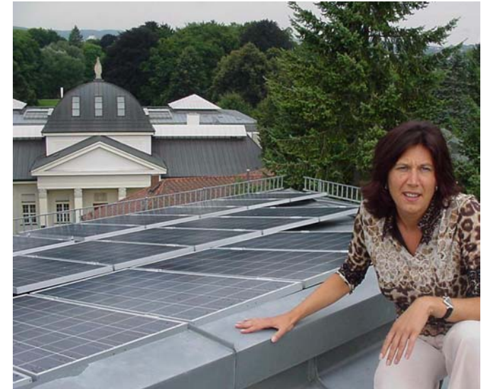
Sonnenstromanlage auf dem Dach des Bund Naturschutz in Regensburg
